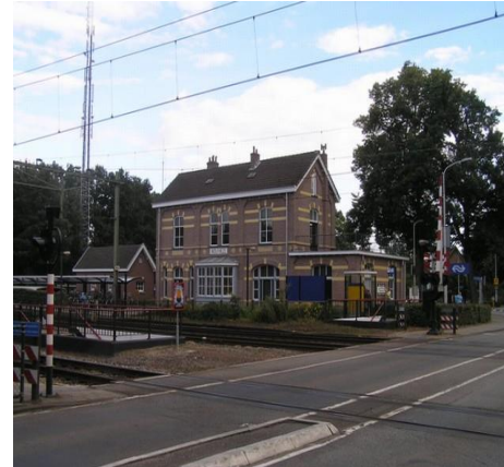
Figuur 27 Stationsgebouw Wolfheze
