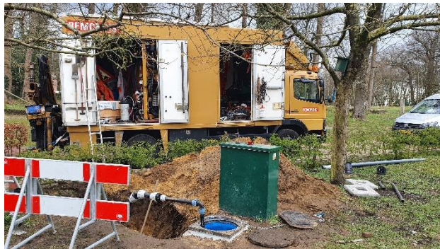
Werkzaamheden aan gemaal Nieuwe Keijenbergseweg, april 2021
