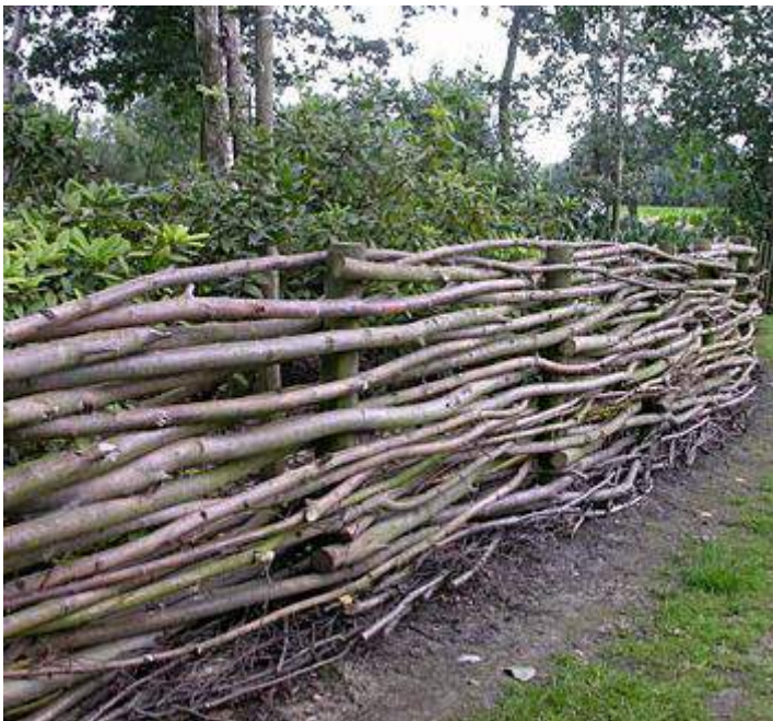
Afb 2. Voorbeeld van een vlechtwerk hek
